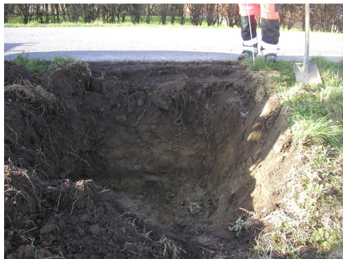
Figur 3. Udgravning ved forsøgsstrækningen på Thorsensvej.
